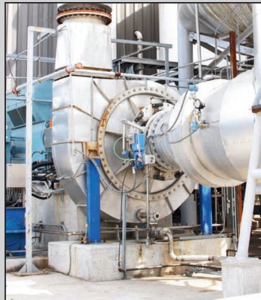
FLÄKT WOODS TURBOFAN MCR COMPRESSOR
